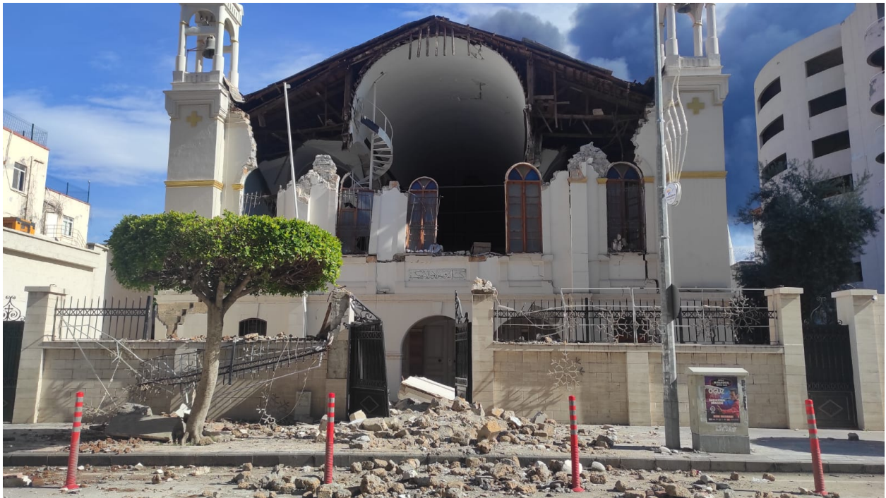
La façade d'une église en Turquie dévastée par le tremblement de terre. L'Église locale a été durement touchée par la catastrophe naturelle du mois de février. (Photo : OPM Turquie)
